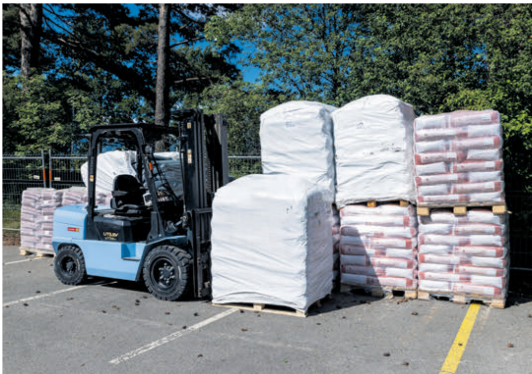
Aktuell wird diese Woche, sofern das Wetter mitspielt, der Asphalt- und Kunststoffbelag für die Leichtathletikanlage verlegt. Das Material dafür steht bereit.
