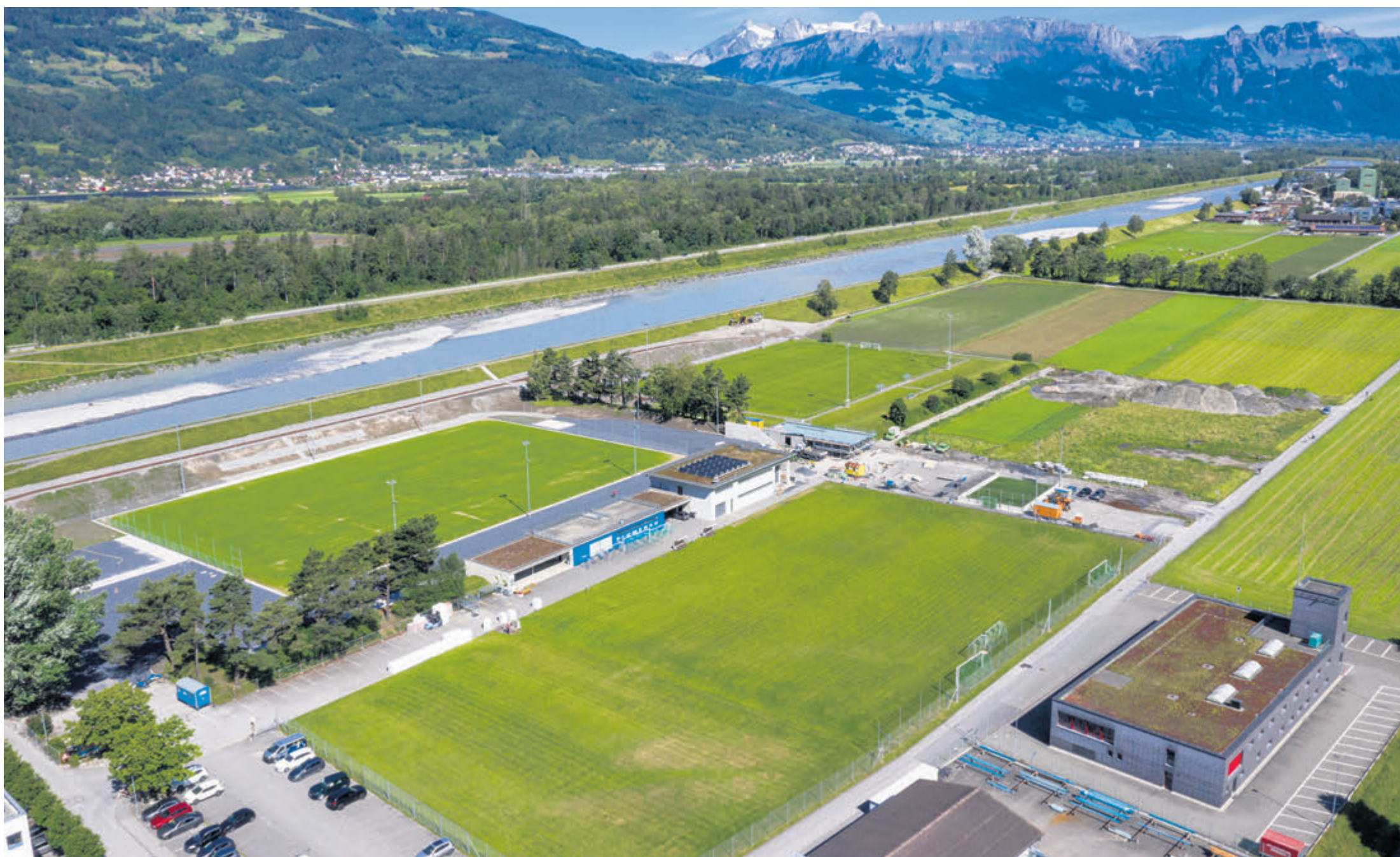
In zwei Etappen baut Triesen einen neuen, grosszügigen Sport- und Freizeitpark Blumenau. Die Bauarbeiten laufen wie geplant, es gab bisher keine Verzögerungen.
